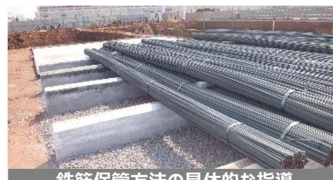
鉄筋保管方法の具体的な指導
