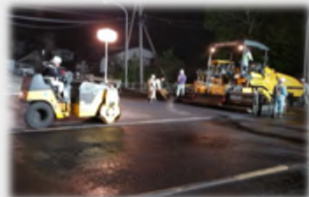
通行不能の交差点での応急工事
