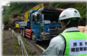
道路啓開(倒木・土砂の撤去)
