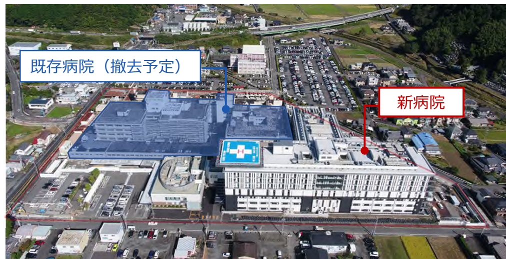
2021年10月撮影（表記無き限り、写真は島田市立総合医療センターHPより） 左奥が旧島田市民病院（撤去予定）、右手前が新病院（島田市立総合医療センター）。 既存病院敷地内での近接施工であり、施工期間中の医療行為の継続が重要となった。
