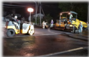
通行不能の交差点での応急工事
