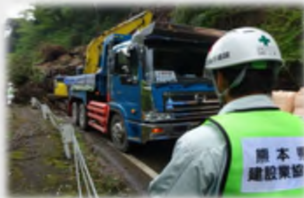
道路啓開(倒木・土砂の撤去)
