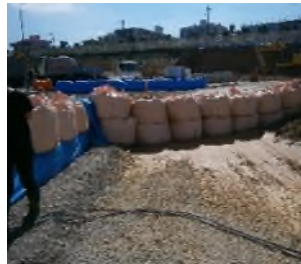
土嚢による流出対策
