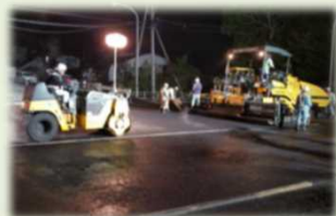
通行不能の交差点での応急工事
