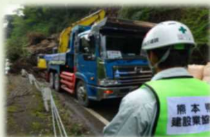
道路啓開(倒木・土砂の撤去)
