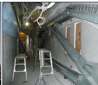
耐震補強仮囲い内状況
