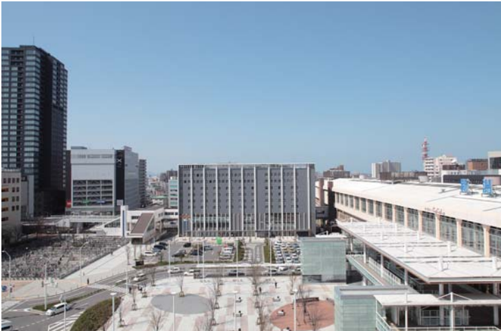
写真1：全景 新潟駅南口広場より
