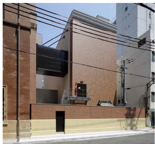
解体後に新築：新南館
