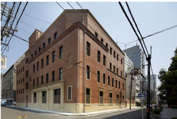
保存・改修：武田道修町ビル（本館・新館）
