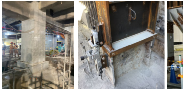
地下既存柱と地上新設柱の接合
