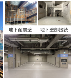
既存躯体＋新設躯体の地下駐車場
