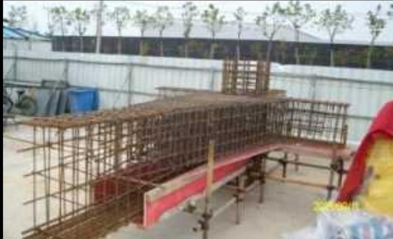
鉄筋モックアップ(PC鋼線)
