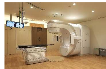
治療室3. 国内で初めて導入した最新鋭の放射線治療装置トゥルービーム
