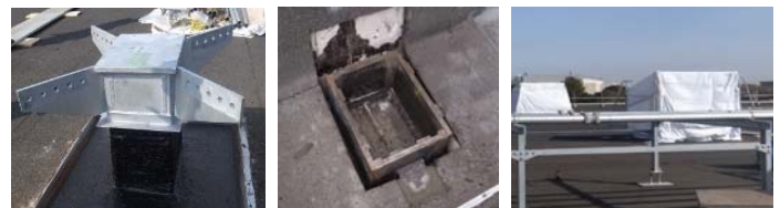
工事中のブレース東材 東材2分割施工(1段目) 雨風避け養生テント
