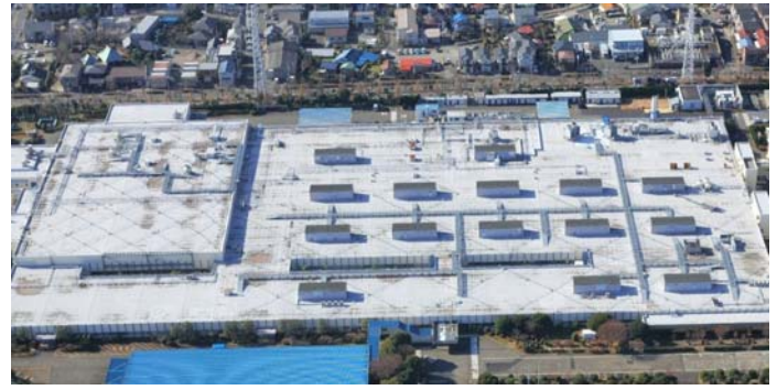
4万㎡規模の工場屋根面の外側に水平補強ブレースを配置 共同公開特許出願中
