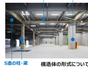
S造の柱・梁 構造体の形式について
